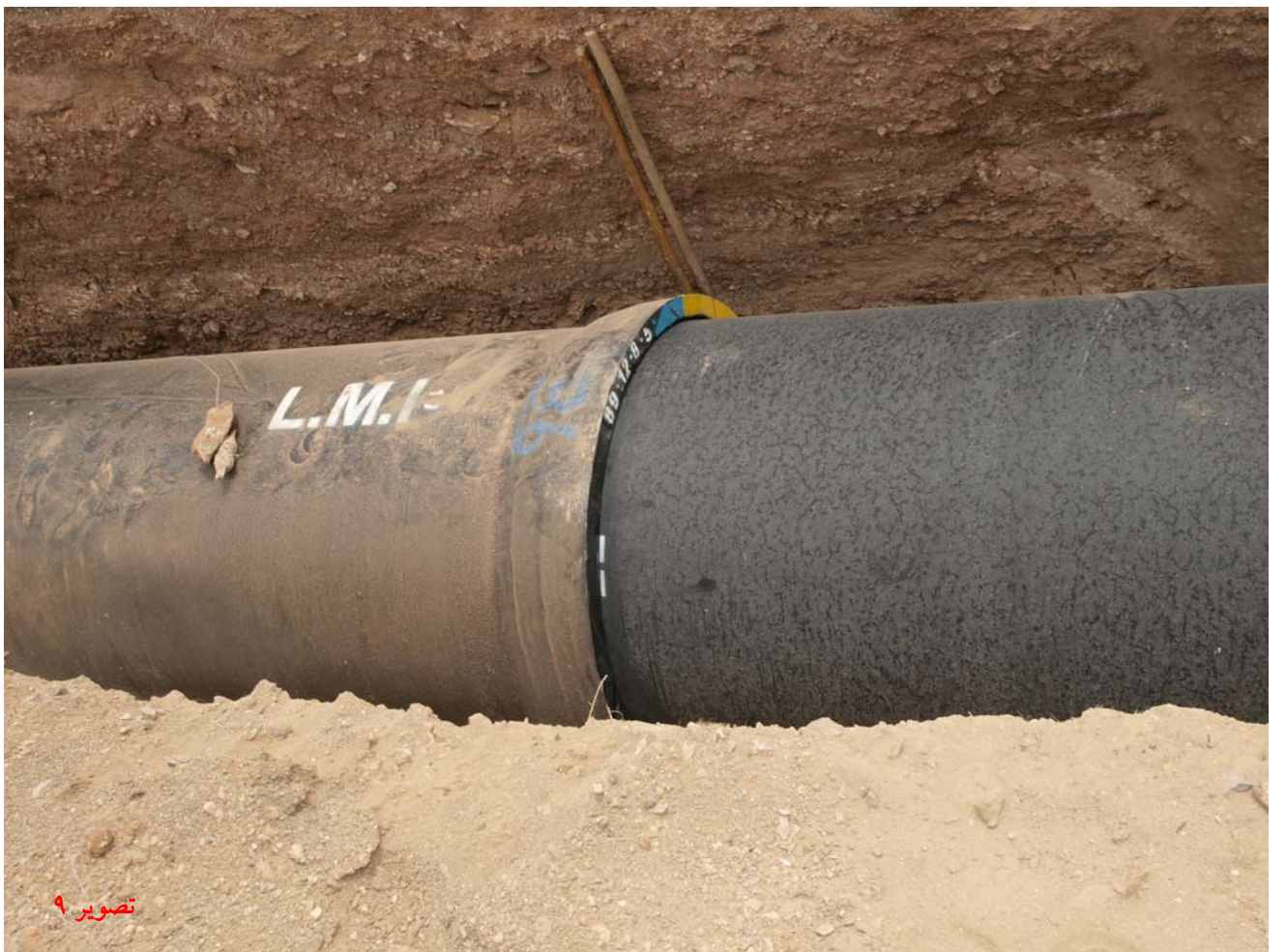
تصاویر ۳ الی ۹-سهولت در مراحل مونتاژ لوله چدنی نشکن سایز ۱۲۰۰ میلی متر را نشان می دهد.
