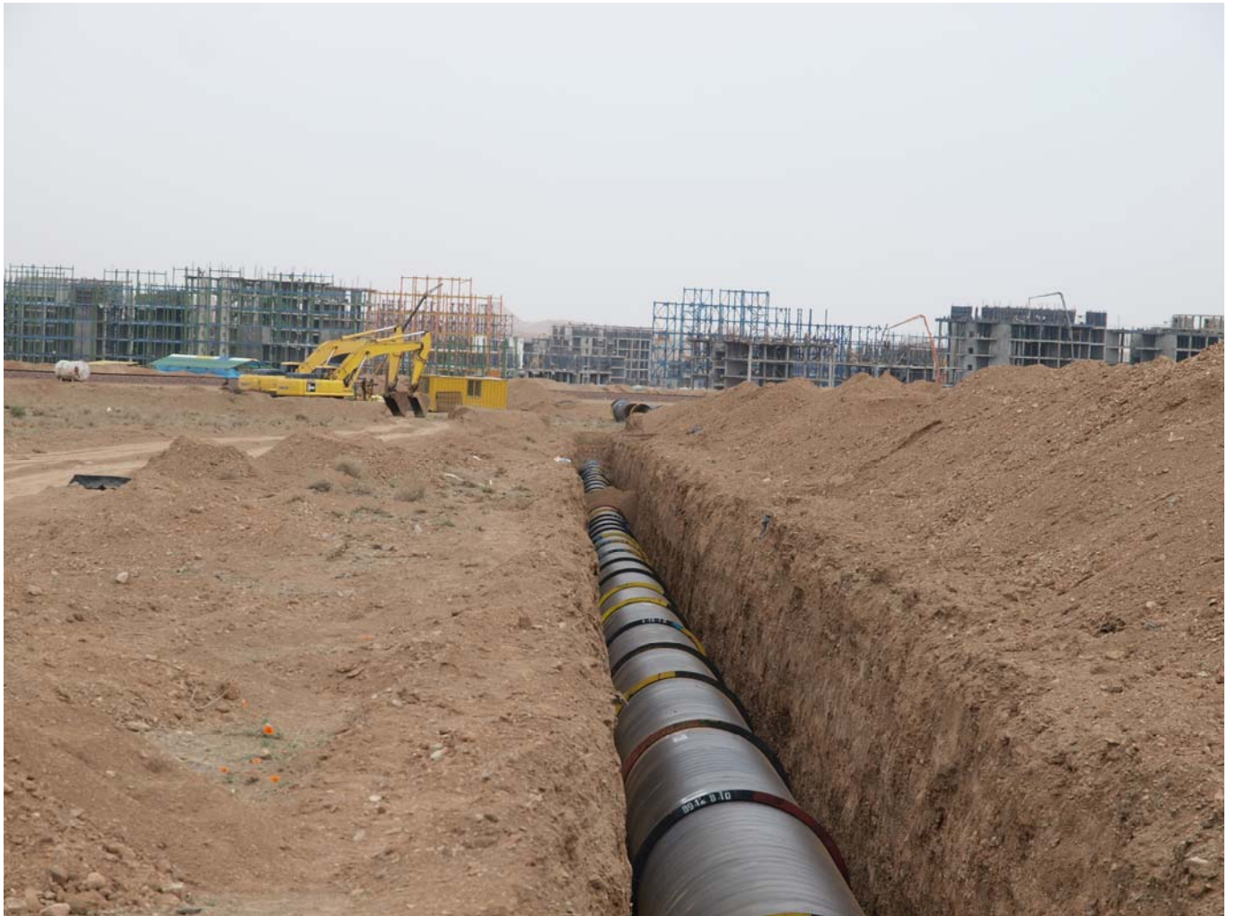
تصویر ۱- مراحل پایانی اجرای طرح آبرسانی به مسکن مهر شهر قم، سایز ۱۲۰۰ میلی‌متر
